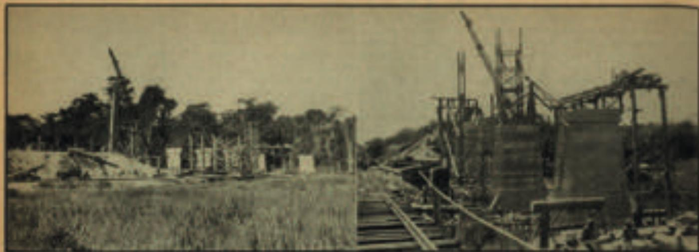
SUBESTRUCTURAS DEL PUENTE DE ZANAPA (IZQUIERDA); LAS PILAS Y CABALLETES TERMINADOS
